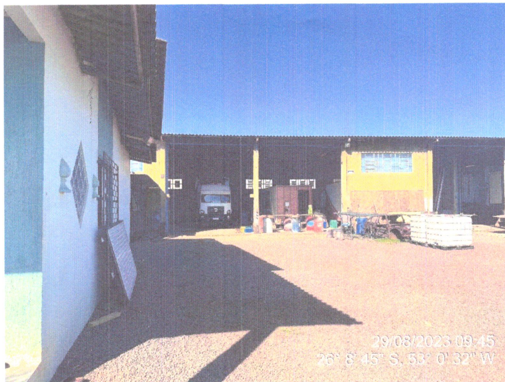
Figura 7 – Vista barracão: lateral.
