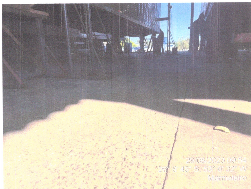
Figura 4 – Vista barracão: revestimento piso.
