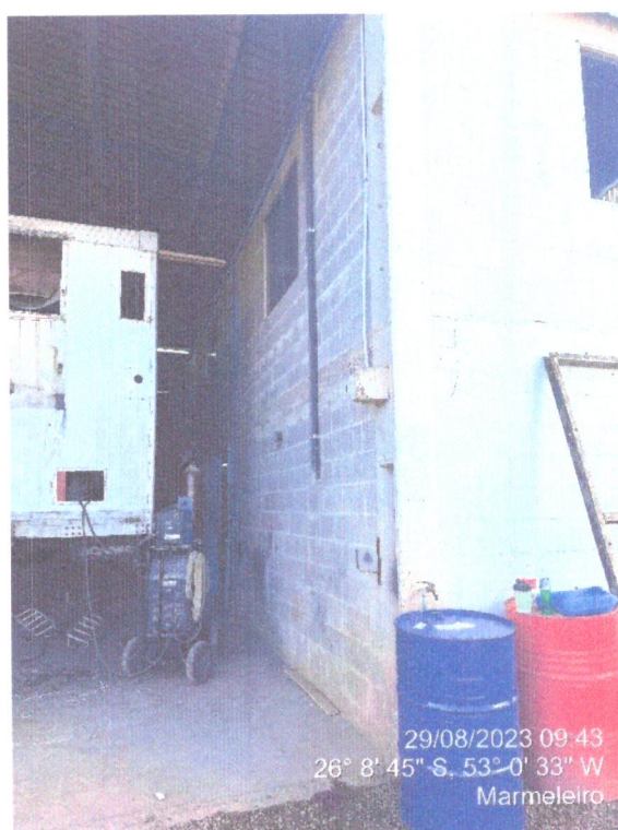
Figura 10 – Vista interna do barracão.
