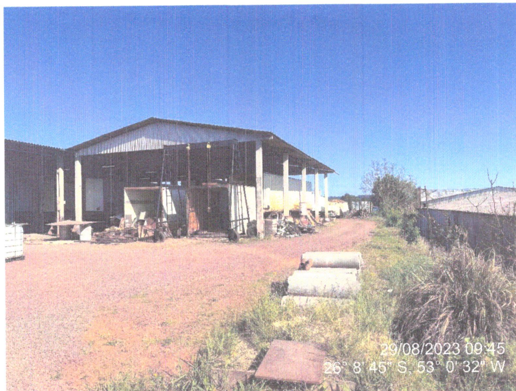
Figura 5 – Vista telheiro: fundos.
