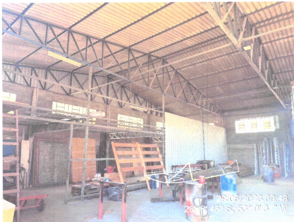
Figura 9 – Vista interna do barracão.
