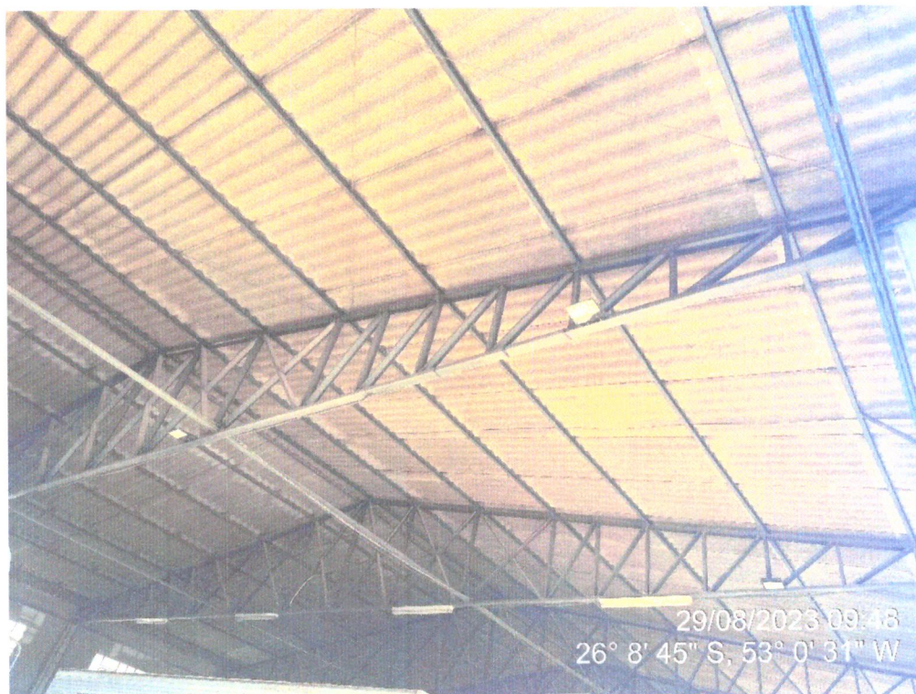
Figura 3 – Vista barracão: parte interna do telhado.
